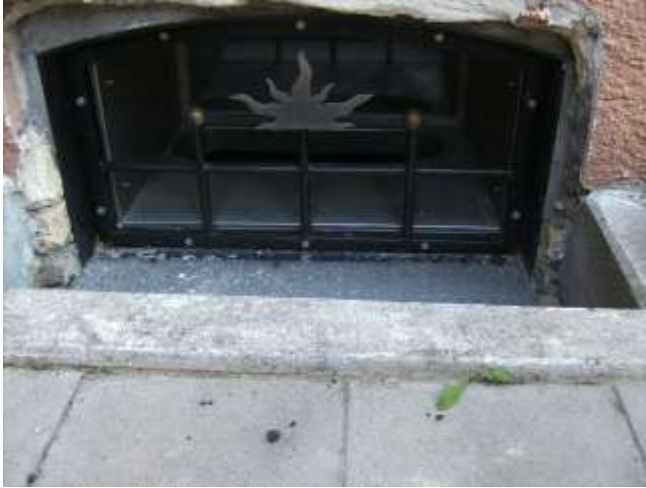
Zu- und Abluft für die Wärmepumpe sind im Kellerfenster und im Sandsteinbogen untergebracht
