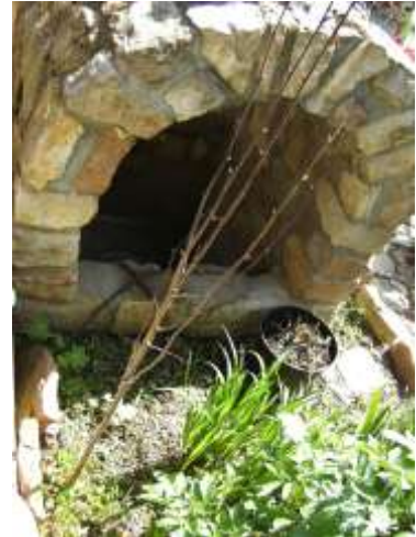
Zu- und Abluft für die Wärmepumpe sind im Kellerfenster und im Sandsteinbogen untergebracht
